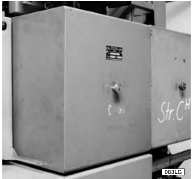
Bild 3.2-2 Relaiskasten für 6 Relais Bauform WSSB I
